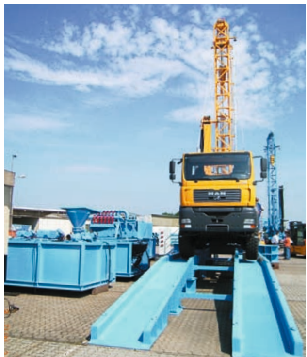
Equipo universal de perforación Prakla con sistema de depósitos de lodos
