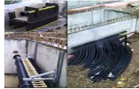
Imagen de la obra: instalación de colector en muro de hormigón insitu.
