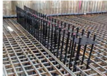
Sistema con soporte de refuerzo y placa guía para fijar a distancia los tubos de paso
